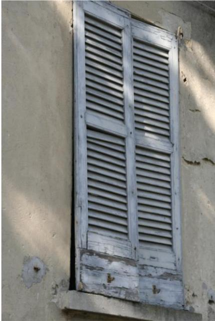
Il prospetto ad Ovest si presenta danneggiato nella fascia di intonaco inferiore, anche a causa della presenza di graffiti. L'interno è caratterizzato da temperature molto basse e da una forte umidità, che ha prodotto la formazione di condensa interna superficiale; questa ha rovinato gli stati di finitura della parete, negli angoli, e la pavimentazione.
