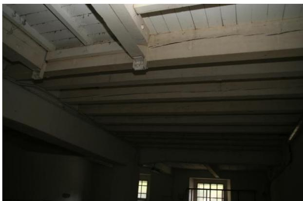
La struttura portante del palazzo è costituita dai muri perimetrali in mattoni e da solai di spessore variabile tra i 30 e i 40 cm, la cui tecnica di posa, si può ipotizzare, tradizionale con travetti e pignatte. Al piano interrato sono anche presenti pilastri singoli e travi a vista, probabilmente per rafforzare la struttura dei muri perimetrali che in tal caso fungono soprattutto da contenimento.
